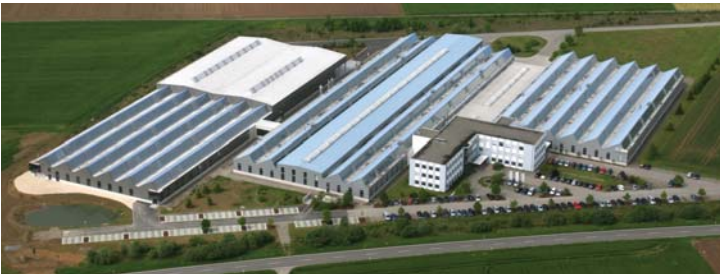
In unserem Werk in Dürmentingen befinden sich auf 37000 qm Fläche die Montageabteilungen, die Konstruktion, der Vertrieb und die Lehrwerkstatt für rund 50 Lehrlinge. Das gesamte PAUL-Areal erstreckt sich über 120000 qm.
