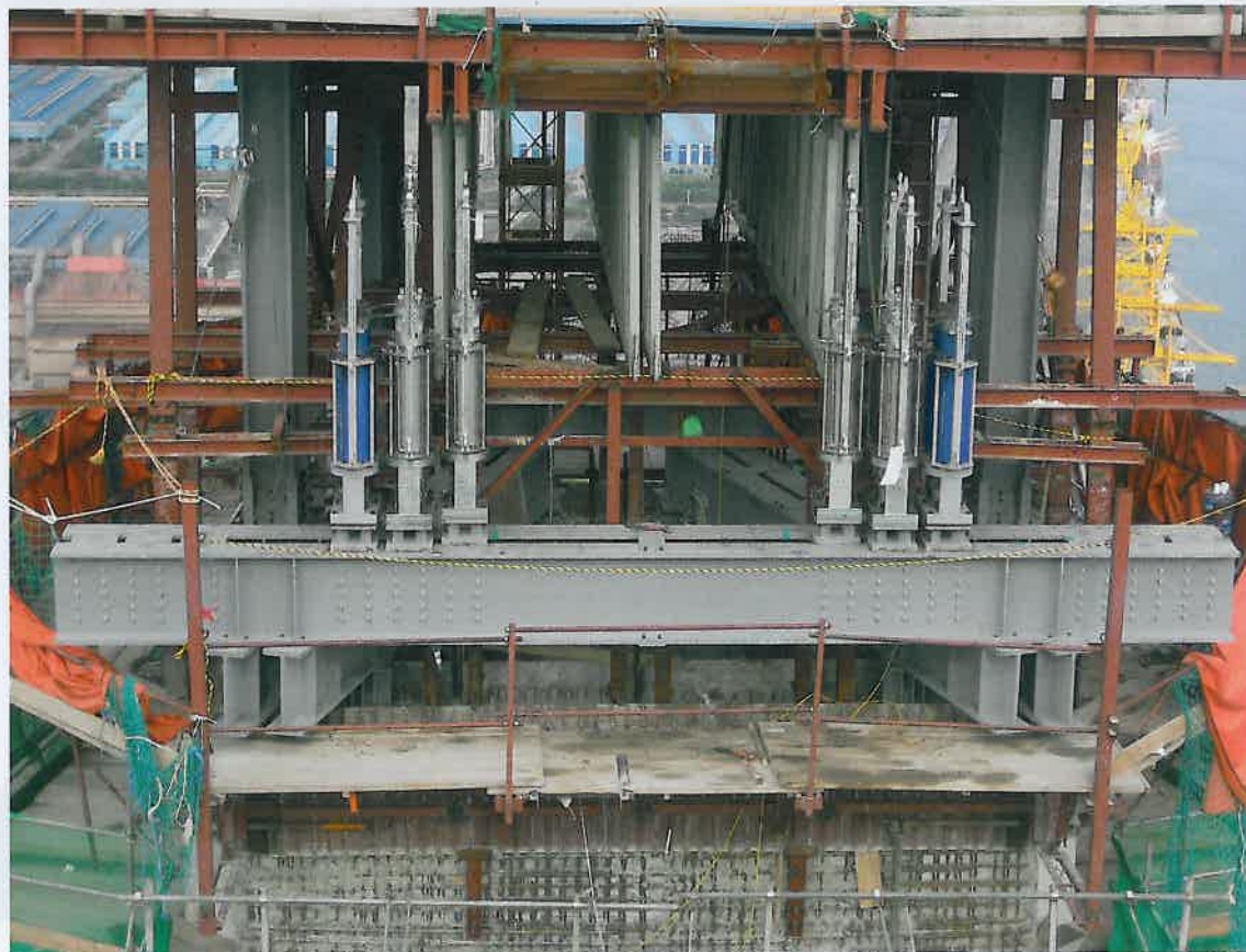
Kleines Gerät, große Wirkung: Mit Litzenhebern werden weltweit allerschwerste Lasten bewegt.
