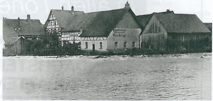
Paul production site in its year of founding in 1925 Paul-Werksgelände im Gründungsjahr 1925
