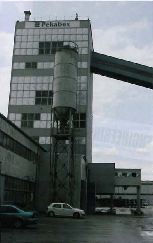
Pekabex produziert außer Betonfertigteilen auch Transportbeton
