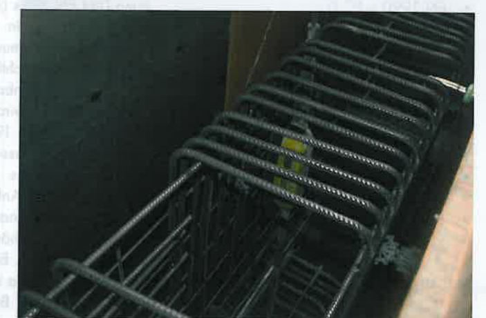
Blick in die Fußfundamentalschalung
