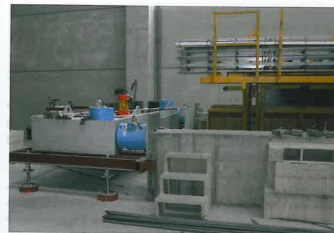
Als Widerlager beim Vorspannen dienen durchlaufende Betonwände auf beiden Seiten der Binderschalung
