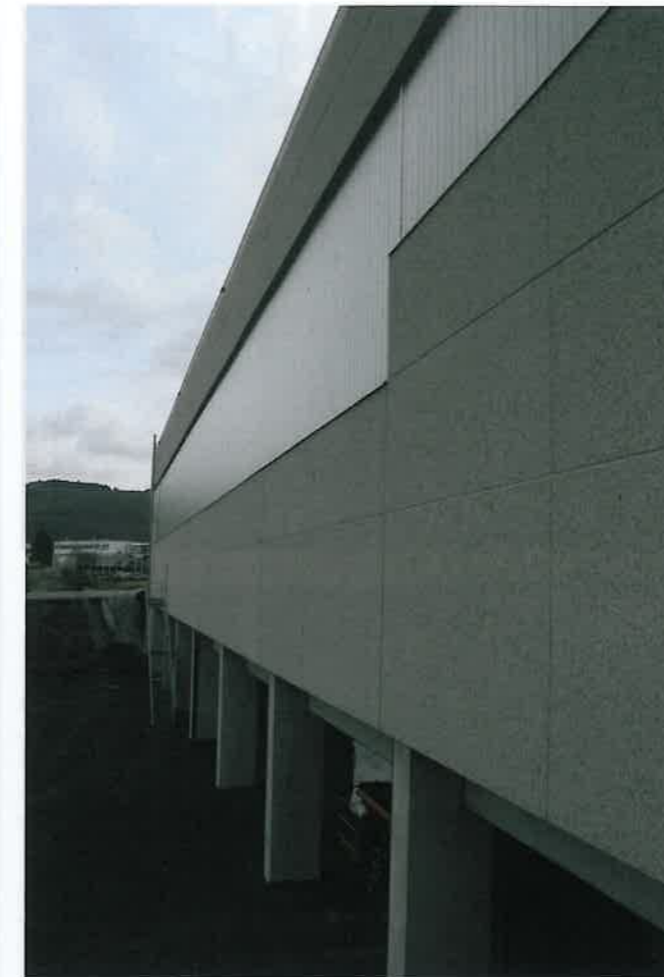
Die neue Halle wurde teilweise in zweigeschossiger Bauweise errichtet.
