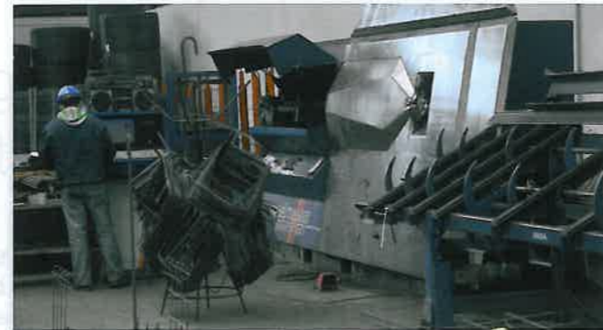
Mit Ausnahme von Betonstahllagermatten fertigt Günther seine Bewehrung komplett selbst
