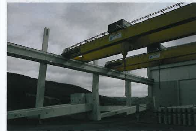
Die Stützen der Kranbahn wurden als komplette Hallenstützen für eine spätere Erweiterung ausgeführt
