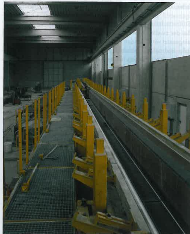
Die Binderschalung ist in vier Abschnitte zu jeweils 13,75 m aufgeteilt
