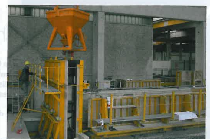
Die neue Fußfundamentalschalung wurde vor die bestehende Zwillingschalung gesetzt
