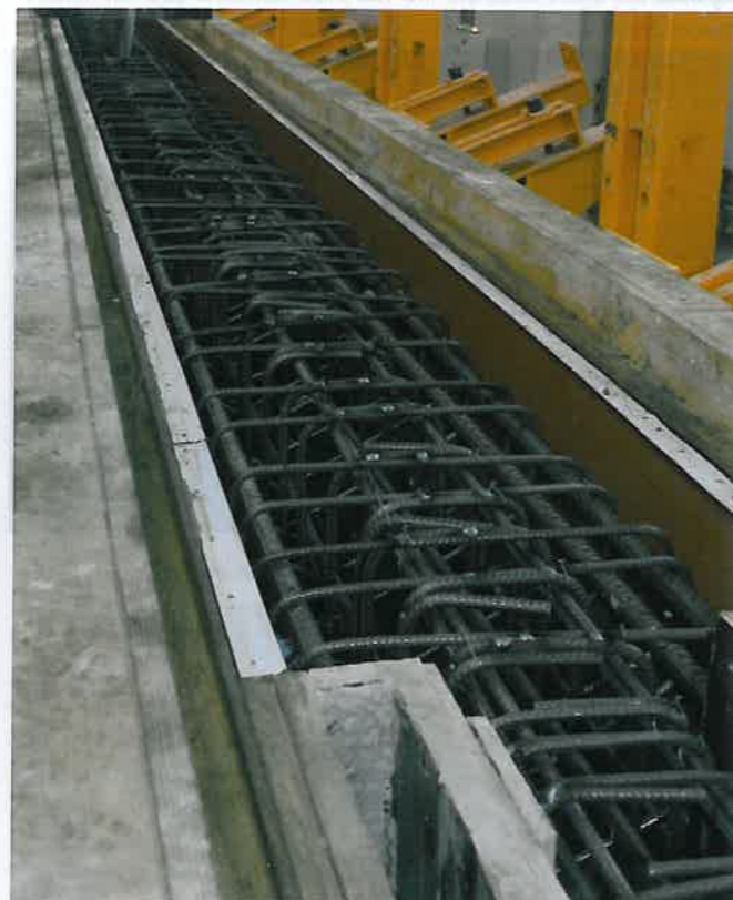
Bis zu einer Bauteilhöhe von 2,30 m können sowohl Parallel- als auch Satteldachbinder mit der neuen Binderschalung hergestellt werden
