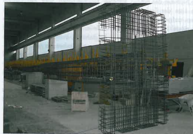
Die Bewehrung für Stützen mit integrierten Fundamenten können jetzt in einem gefertigt werden
